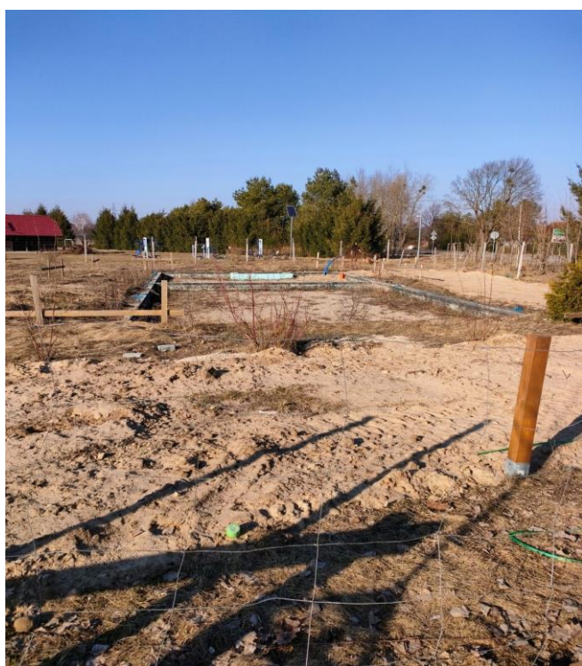
Fundamenty pod budowę świetlicy w Giedajtach:
