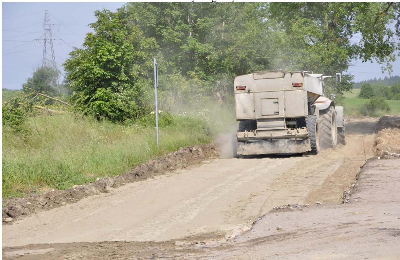
W trakcie budowy drogi Mątki - Wilimowo
